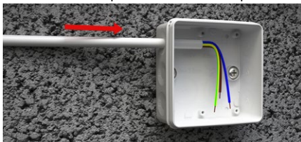
1. Insérer le câble par la membrane souple
