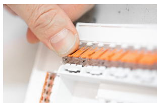
Verrouiller la borne dans le support
