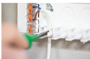
Positionner les câbles dans les décharges de traction
