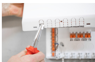
Enlever l'opercule du couvercle
