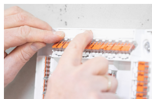
Positionner le marquage dans le support
