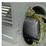
Moteur sur plots antivibratiles
