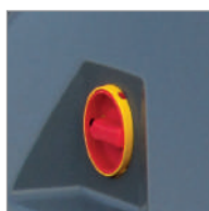
Inter de proximité monté et câblé
